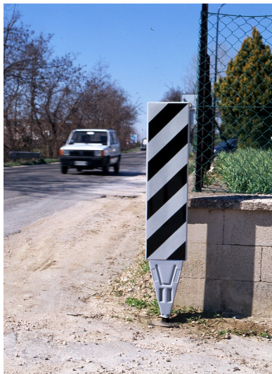
Evidenziazione ostacolo con pannello rifrangente. An obstacle signalled by a reflective panel
